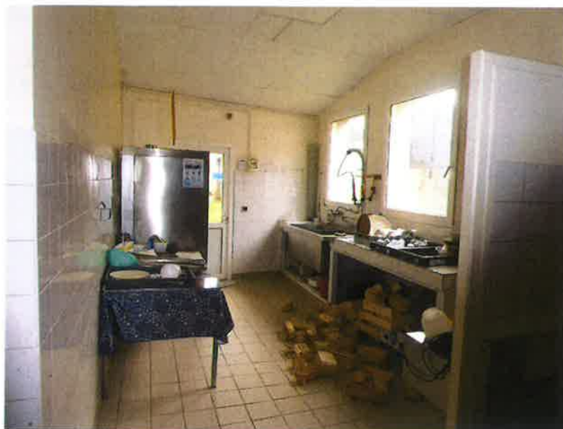
Deux fenêtres en PVC double vitrage donnant sur la cour à l'arrière.
