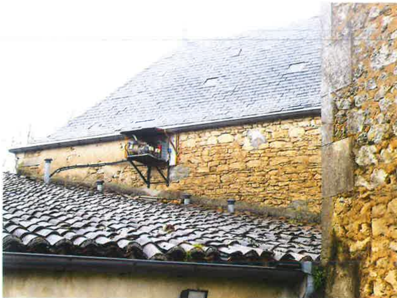
Côté extérieur, les façades sont recouvertes d'un enduit ancien.
