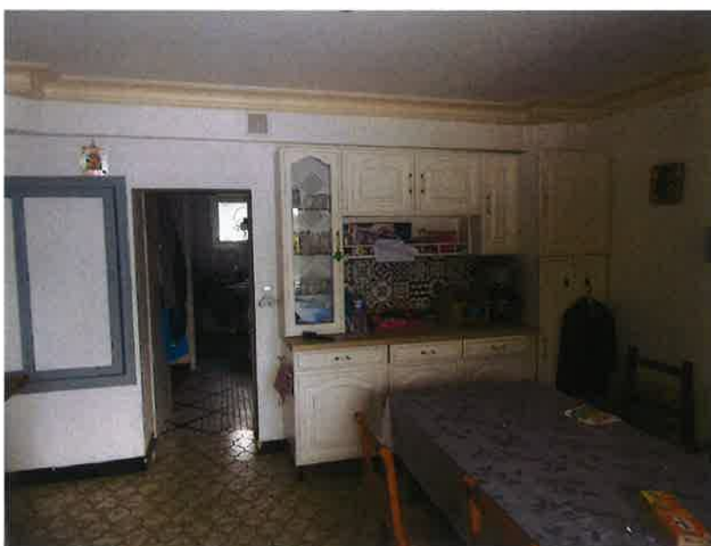
Une crédence en carreaux de ciment récents.
