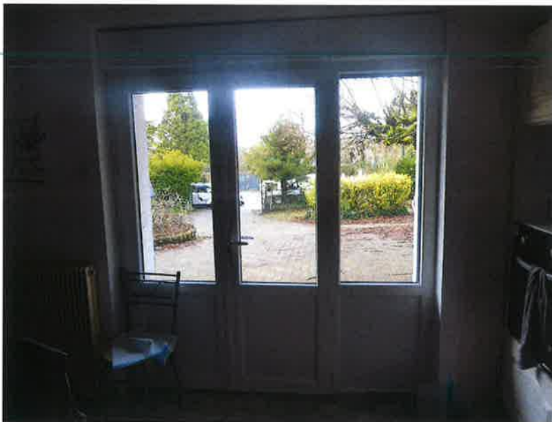
Un radiateur de chauffage central.
