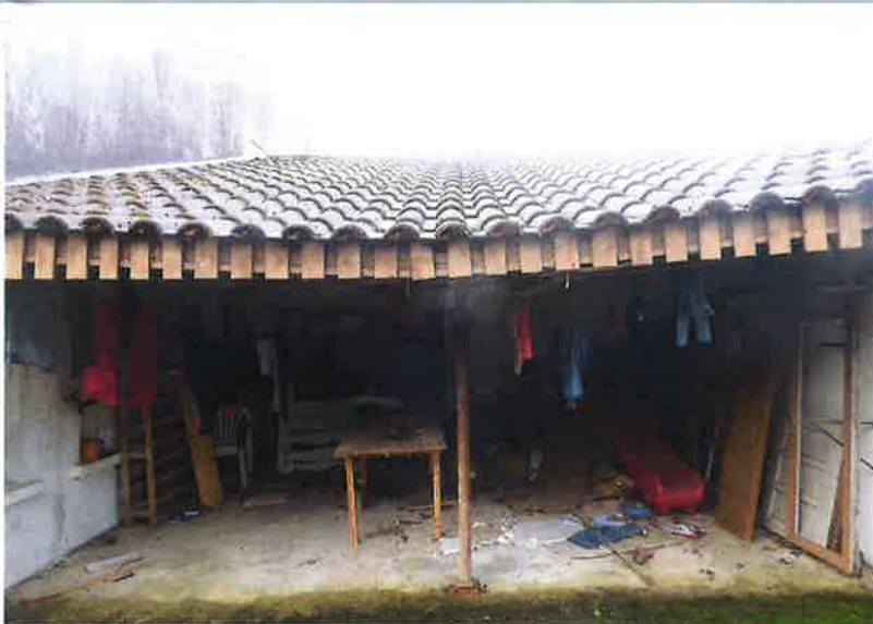
La façade arrière est recouverte d'un crépi ancien.
