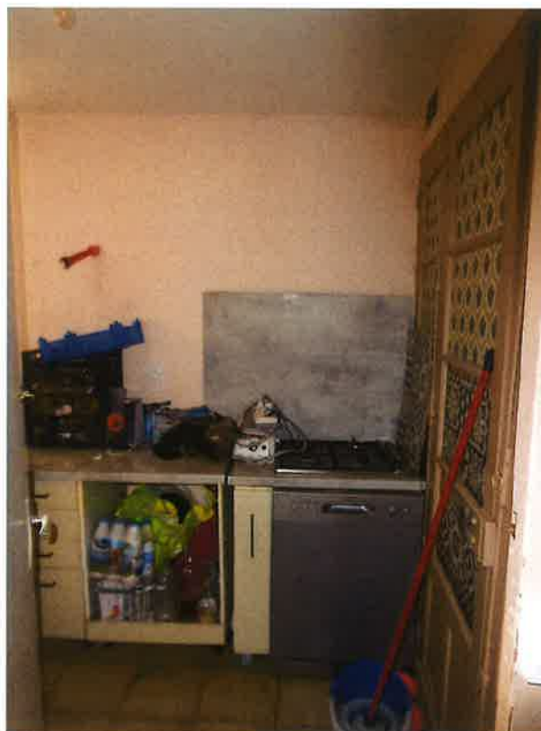
Une porte de service en PVC qui donne sur l'extérieur et sur l'arrière de la maison.
