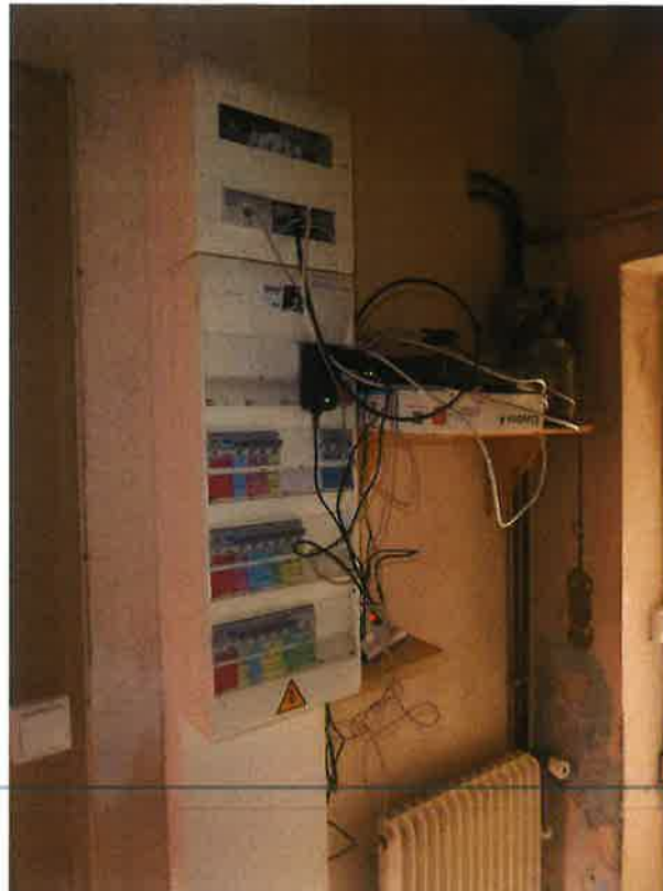
Un radiateur de chauffage central.
